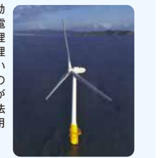
浮体式洋上風力発電 (写真提供:長崎県五島市)
